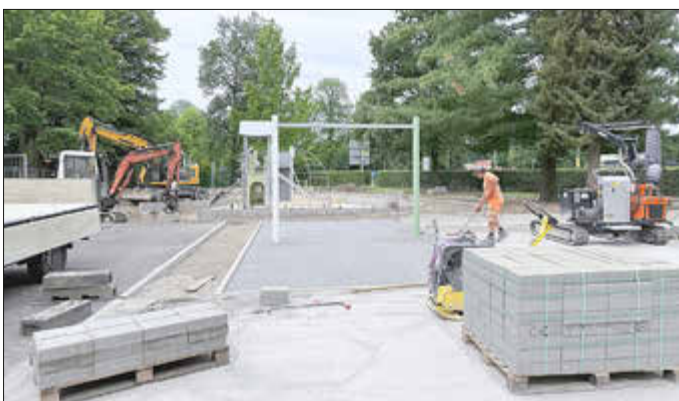
Bauarbeiten am 8. Juli 2026
